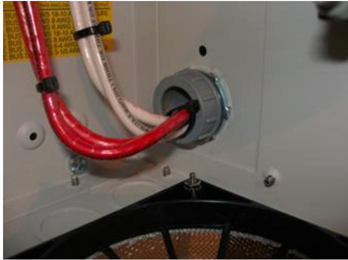
Figure 18-PV Conduit
